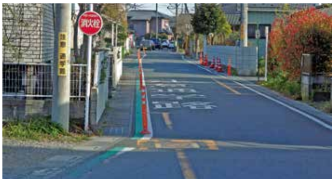
すれ違いも大変な奥富地区・前田通り
